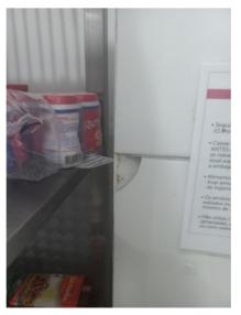
✔ Presença de extintor sendo utilizado para segurar a porta e sem identificação.
